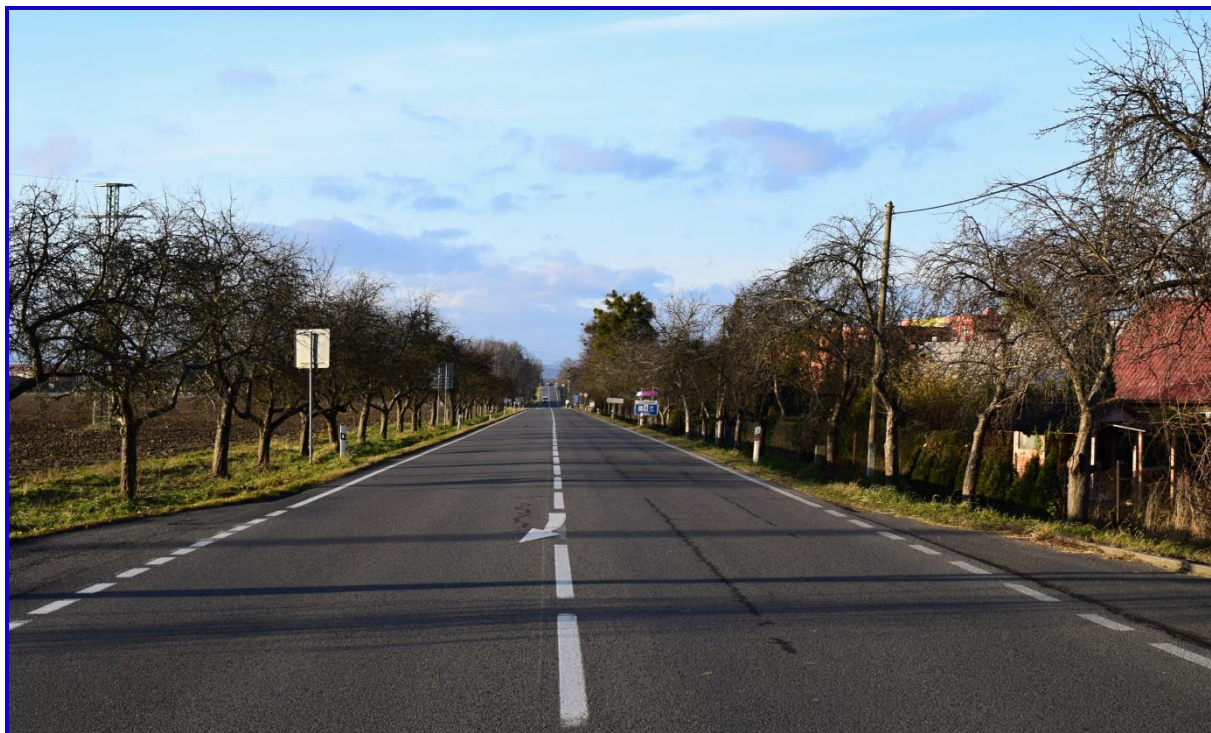
Obrázek č. 19: Silnice č. II/648
